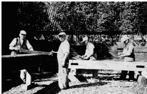
Tømmerne i gang med at tilvirke det kraftige egetømmer under Clemmensens tilbageførende restaurering af Møntergården i 1938-39. (Odense Bys Museer)
